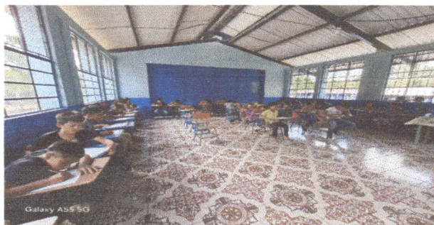
FINALIZACION DE LA COLOCACION DEL CERAMICO
